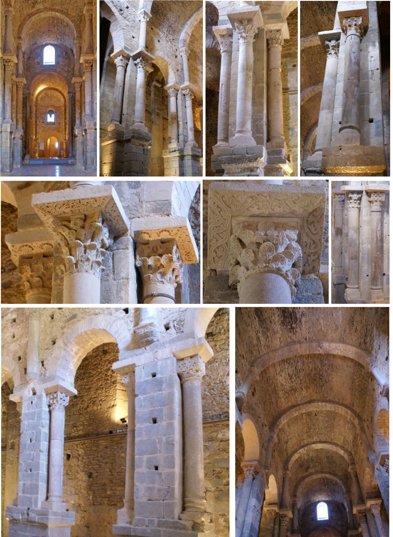
Il·lustració 228: església de Sant Pere de Rodes. 228a. Superposició de columnes / 228b. Suports de l'est / 228c. Columna de la nau centrada en pilar / 228d. Columna de former descendent de pilar / 228e. Blocs d'imposta / 228f. Imposta com a àbac / 228g. Imposta com a entaulament / 228h. Suports de l'oest / 228i. Torals i columnes superiors.
