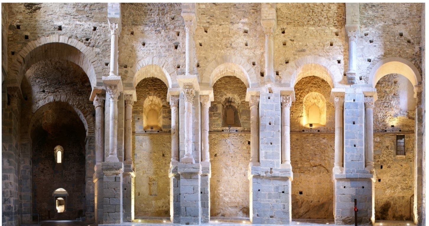
Il·lustració 243: església de Sant Pere de Rodes. Fotomuntatges dels alçats nord i sud de la nau: els suports de tres columnes sobre pilar i la superposició de columnes; els suports de dues columnes sobre pilar sense superposició de columnes; la successió dels formers. 243a. Alçat nord. / 243b. Alçat sud.
