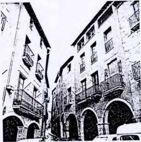
Rehabilitació de les cases 10-11 i 14.
