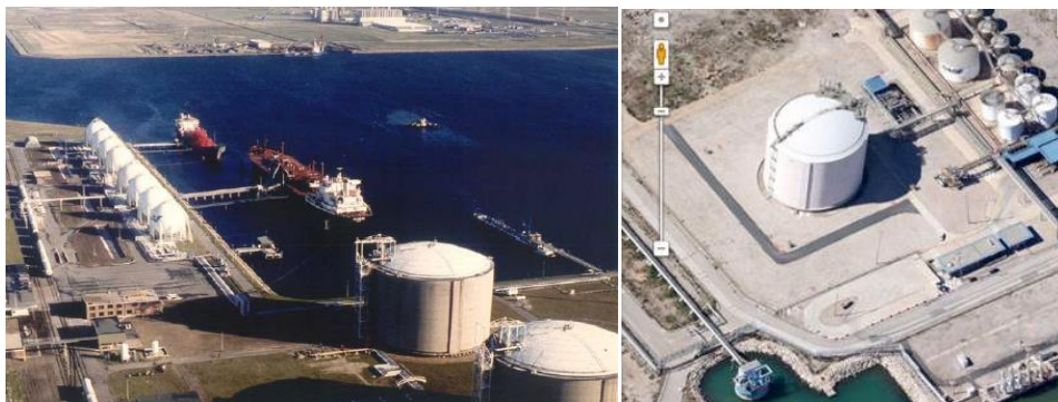
Fig. 6.2 a) Terminal de almacenamiento de GLP en Amberes, Bélgica: dos tanques de GLP refrigerado con una capacidad de 50000 m 3 y ocho esferas de 3300 m 3 con GLP presurizado. b) Vista aérea de un tanque de almacenamiento de propano refrigerado en Tarragona, España.
