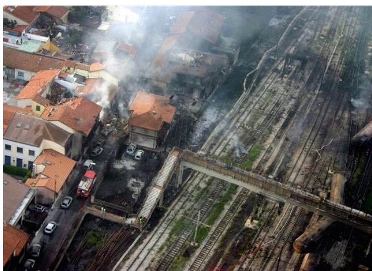
Fig. 1.1 Vista aérea de la estación de tren de Viareggio (Italia), tras el accidente ocurrido en Junio de 2009 (Associated Press).
