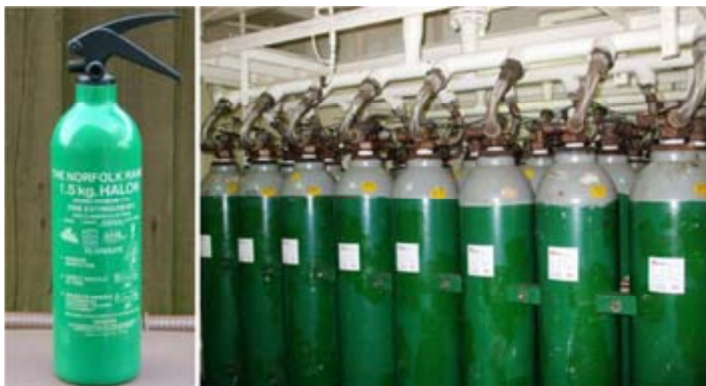
Figura 14 Extintor de mà (esquerra) i sistema d'extinció d'incendis a bord d'un vaixell (dreta), ambdós usen tecnologia Halon®.
