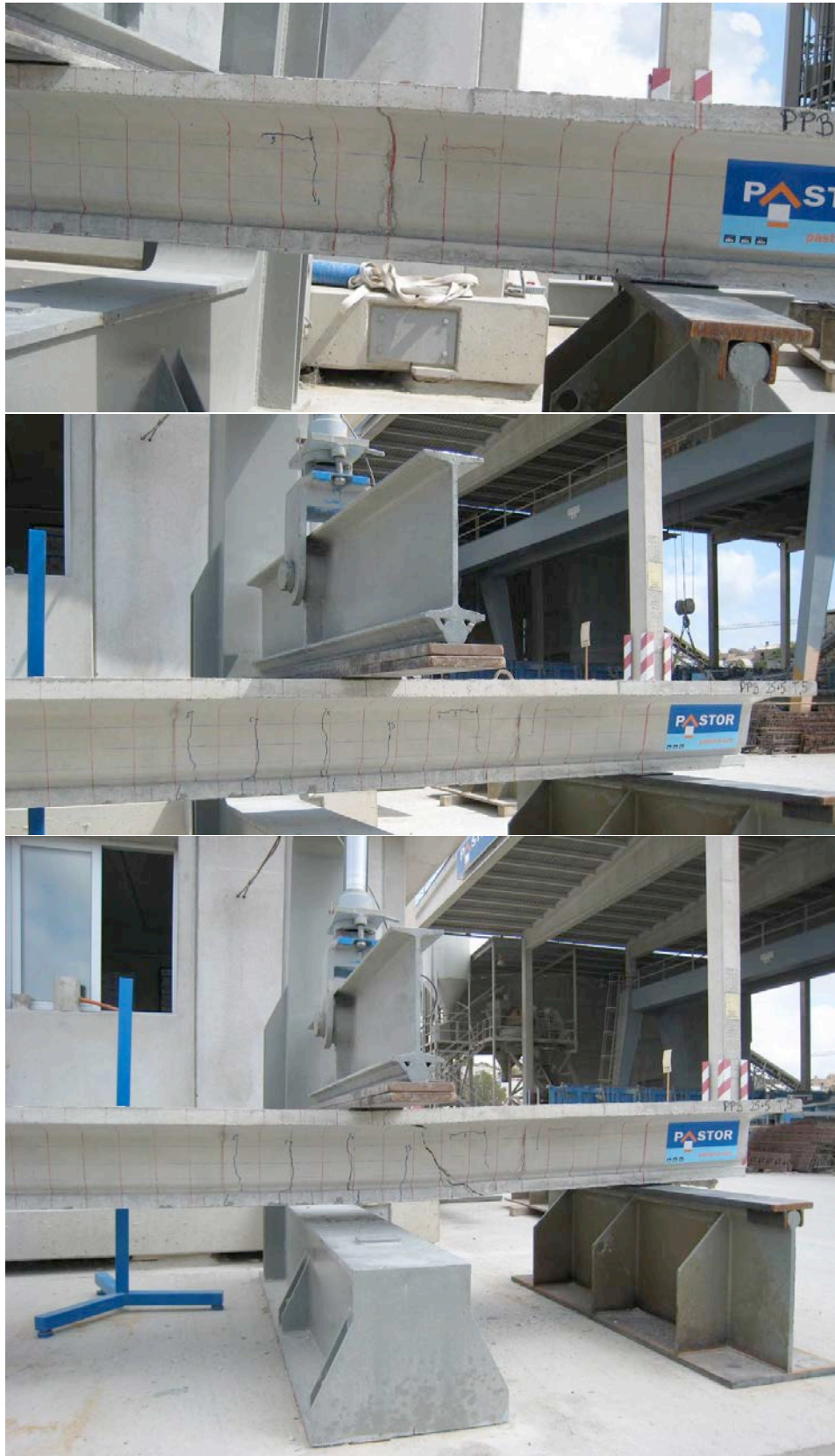
Figura A.6: Fisuración durante el ensayo, 30-T5-T12-CC5.
