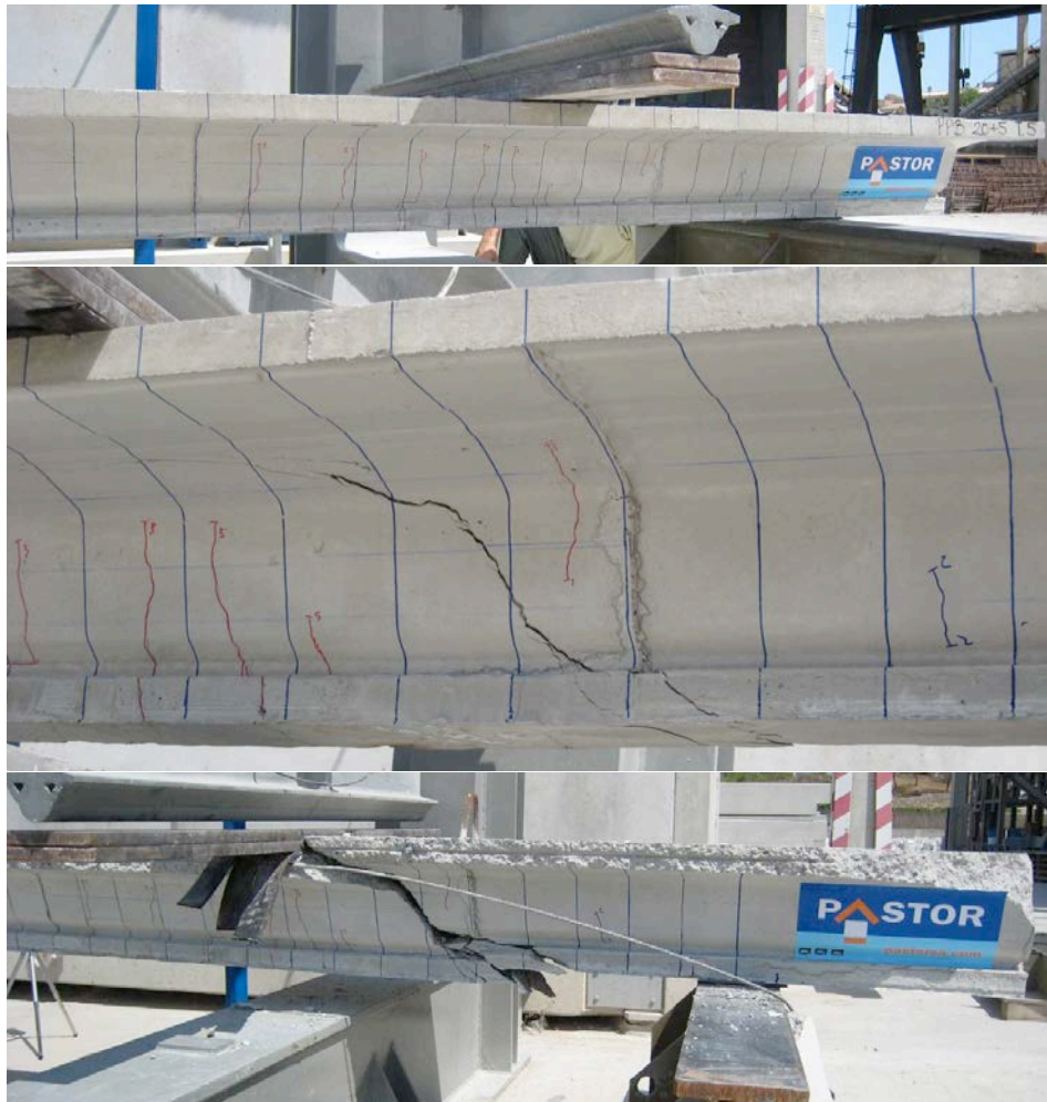
Figura A.12: Fisuración durante el ensayo, 25-T5-T12-CC5.
