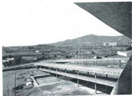
Fig. 23. — Vue en ascendant des gradins vers l'arcade des tribunes, rampes d'accès au stade l'éclaircissement sur la voie profonde.
