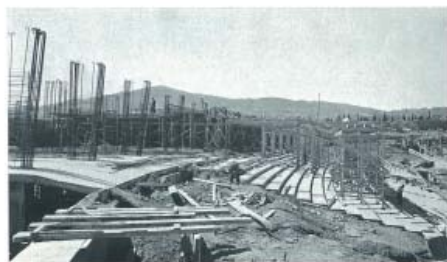
Fig. 20. — Vue montrant le montage des poutres métalliques verticales destinées à supporter l'ossature et la mise en place des gradins inférieurs.
