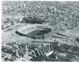
FIG. 25. — Vue prise par avion durant les travaux de construction. Au devant déjà, l'étrépan d'embouteillage apparemment au club de football de Barcelone.
