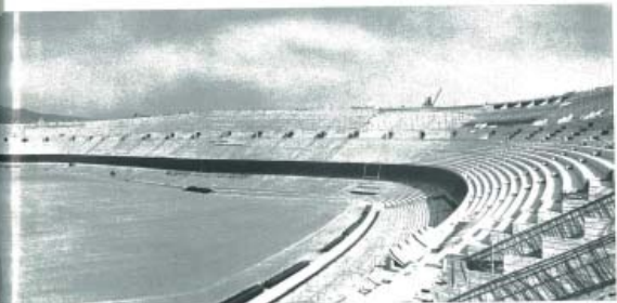
Fig. 13. — Vue des gradins et tribunes de la tribune inférieure. Toutes les pièces des armoires furent réalisées dans 32 et même 32 ans de chantier. On y employa jusqu'à 130 hommes par jour.
