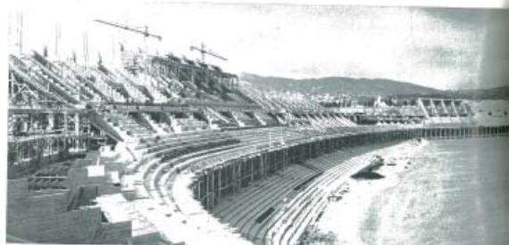
Fig. 12. — Vue des gradins et tribunes de la tribune supérieure. À gauche, armoires sur le chantier même, qui disposent de câbles sous électricité, certains sont équipés avec équipes de soudure électrique et autres équipes de soudure autogène.
