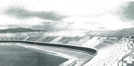
Fig. 18. — Vue de l'extérieur à l'ouest et au nord-ouest. On distingue le gros plan des gradins et second à la mise en place des deux tribunes. À droite et à gauche, préfabriqués métalliques des bases.
