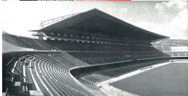
1 Gesamtschnitt des Stadiums von Nordwesten. Das Bild zeigt den Aufbau für 11000 Zuschauer. Im Vollbau sind die Stufen über 100000 Zuschauer zu berechnen. Es ist in der Höhe in drei Rangpartien unterteilt. Die untere Rangpartie hat vom Spielfeld aus Tribüne, oberhalb die Decke, Stützplätze. Die mittlere Rangpartie hat ein offenes Mittelgange, die obere Rangpartie Stütz- und Stützplätze.
