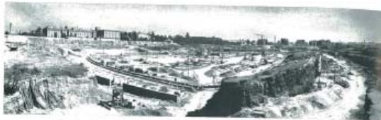
Fig. 10. — Vue des travaux. Cette section est à la suite — 7 m. La construction est entreprise dans les quatre secteurs à la fois (voir plan fig. 1). Cette section inclut une installation centrale de chauffage. On est revenu à quatre bétonnières de 200 litres de capacité, équipées chacune d'un moteur électrique de 2 CV.
