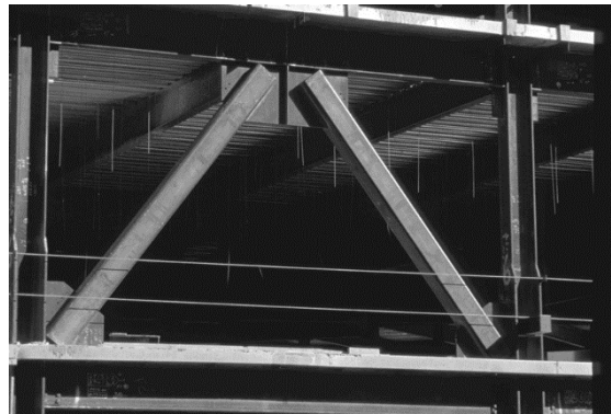
(d) Detail of a CBF building
