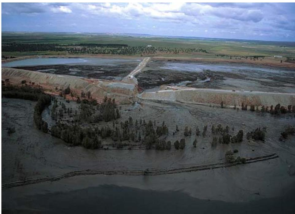
**Figura 8.10: Fotografía que muestra la rotura del muro de contención de la balsa de estériles .**
