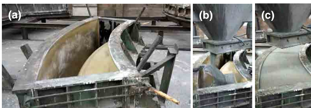
Figura 7.4. a) Molde metálico, b y c) Proceso de vertido del hormigón
