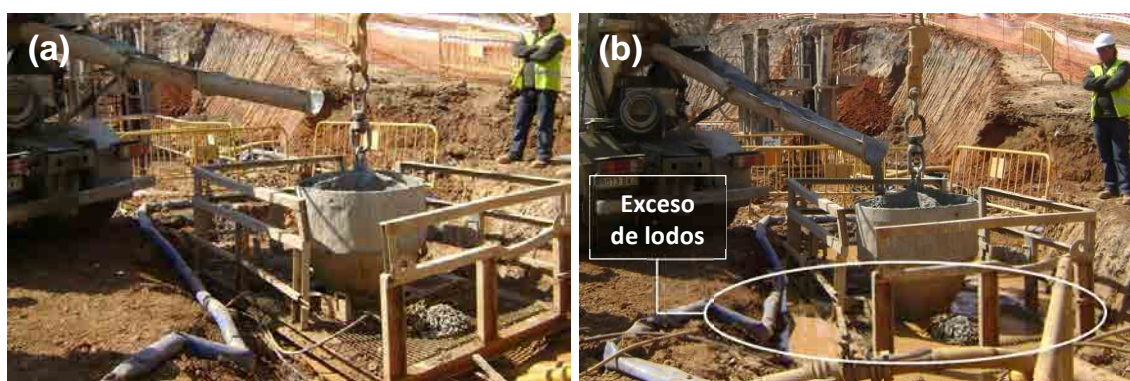
Figura 4.12. Procedimiento constructivo Batache #1, a) Inicio, b) Fin
