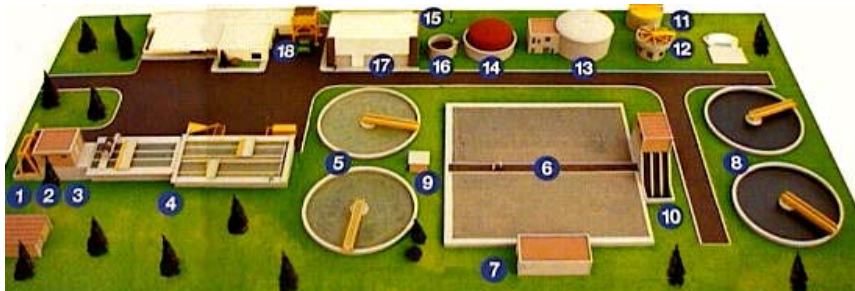
Figura 5.1 Estació depuradora d'aigües residuals amb digestió anaeròbia. 1
