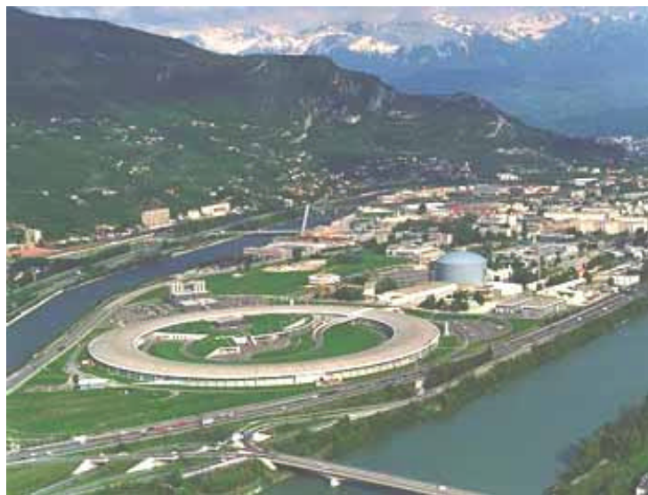
Figura 3.1. Vista aèria de la instal·lació europea de llum de sincrotró ESRF ( European Synchrotron Radiation Facility ), situada a Grenoble (França) i utilitzada per dur a terme els experiments. L'anell d'emmagatzematge, de 820 m de circumferència, conté prop de 40 línies de llum que aprofiten els raigs X que emeten els electrons [ESRF, 2000a].
