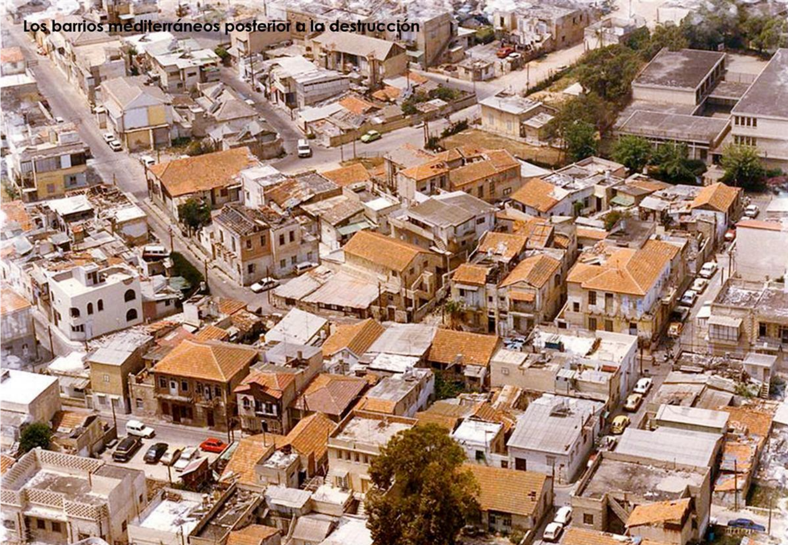
(46) El deterioro físico del barrio Mahane Yosef. Imagen de la década de 1980.
