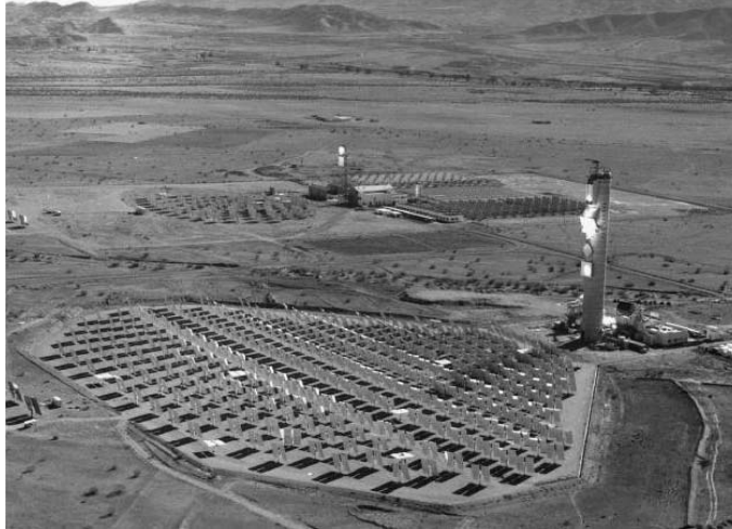
Fig. 3.- Vue aérienne de la plate-forme solaire d'Almeria. Au premier plan la centrale CESA-1 (80 m) avec ses héliostats, au niveau des 60 m de la tour, le receveur de type REFOS. Au second plan, le champ d'héliostat de la centrale CRS. (source site web http://www.psa.es/webeng/index.html )[7]
