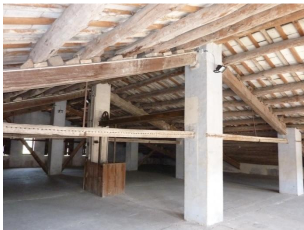
120. Embigat de la coberta. Al centre s'observa la instal·lació de l'ascensor
