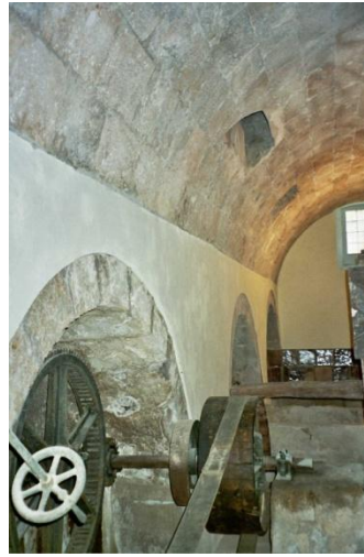
Cal Munné (Cal Farreras) Voltes i arcs de pedra en les dues naus transversals Pilar de pedra i bigam de l'entrada
