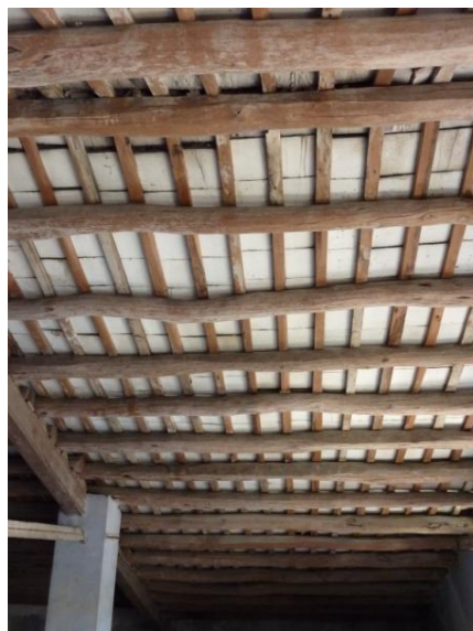
Cal Munné, Conjunt i detall de l'embigat, sustentat per pilars i format per jàsseres, bigues, llates i rajoles
