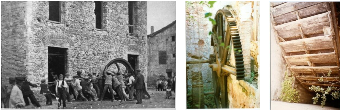
Tasca d'instal·lació d'una roda (MMPC). Sembla ser al molí de Cap d'en Pont. En aquest cas, podria ser la mateixa de les fotografies (any 1987)
