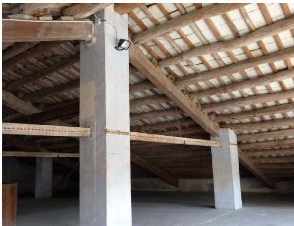
Cal Munné, Conjunt i detall de l'embigat, sustentat per pilars i format per jàsseres, bigues, llates i rajoles
