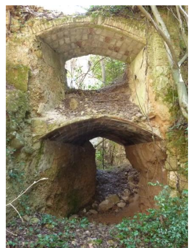
Cal Tiana Doble volta de maó de pla
