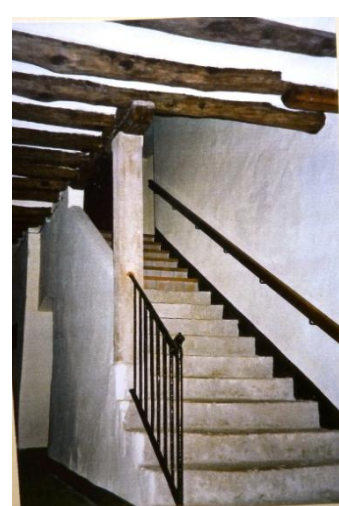
Cal Munné (Cal Farreras) Voltes i arcs de pedra en les dues naus transversals Pilar de pedra i bigam de l'entrada
