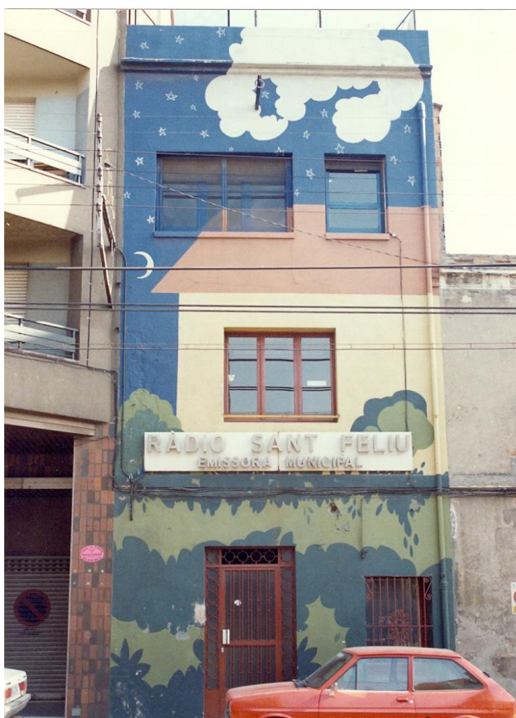
Imagen 90. Fachada del nuevo edificio de Ràdio Sant Feliu
