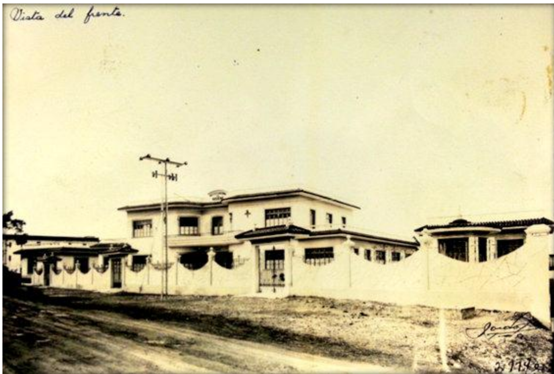
Figura n° 23. Vista Frontal Del Edificio del Instituto Sanitario Nacional.
