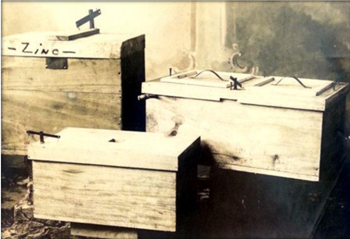
Figura 17. Cubiertas de madera para los depósitos de agua de consumo humano.
