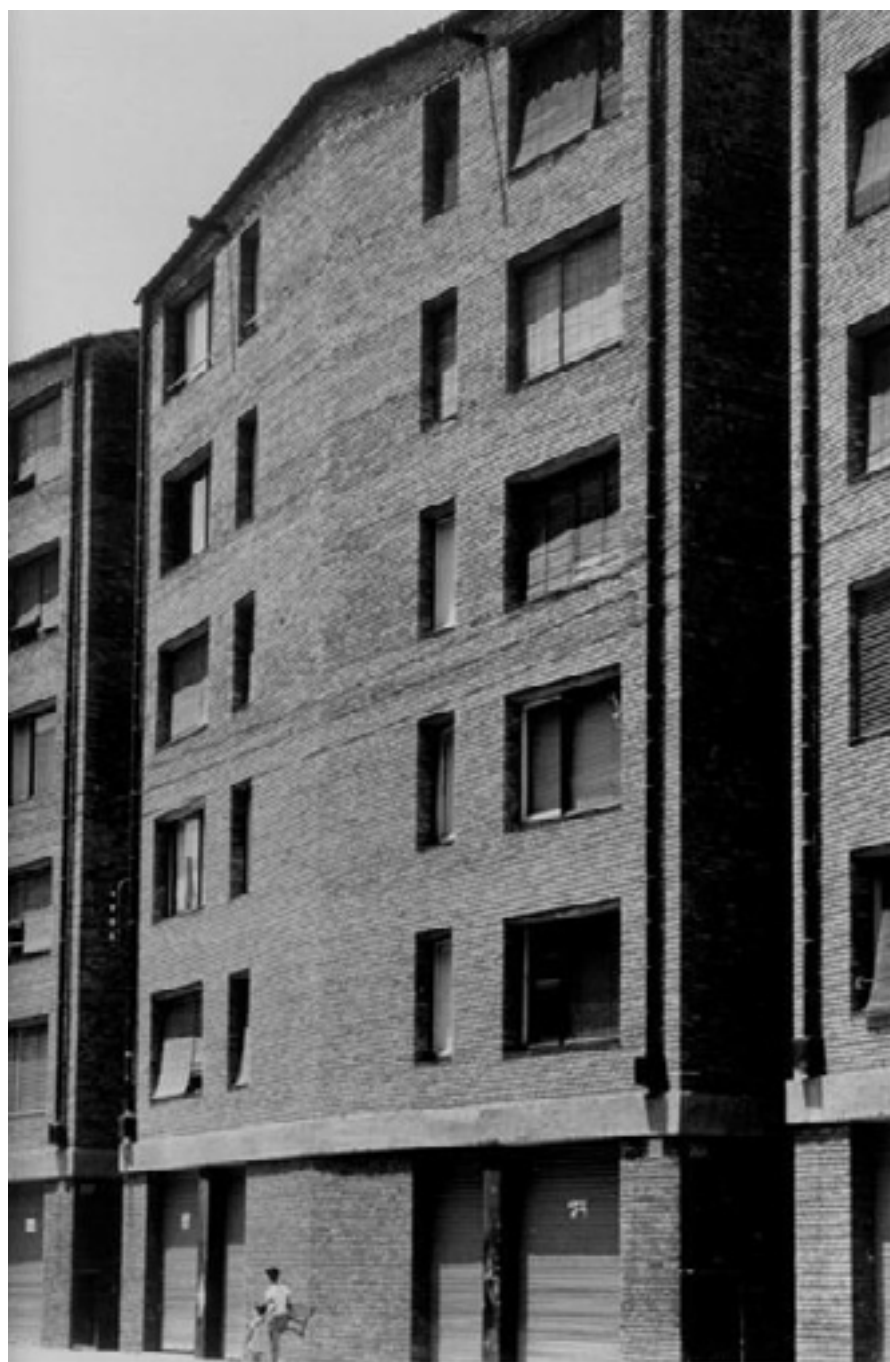
[II.C.5] Façana al carrer Pallars amb fragmentació volumètrica
