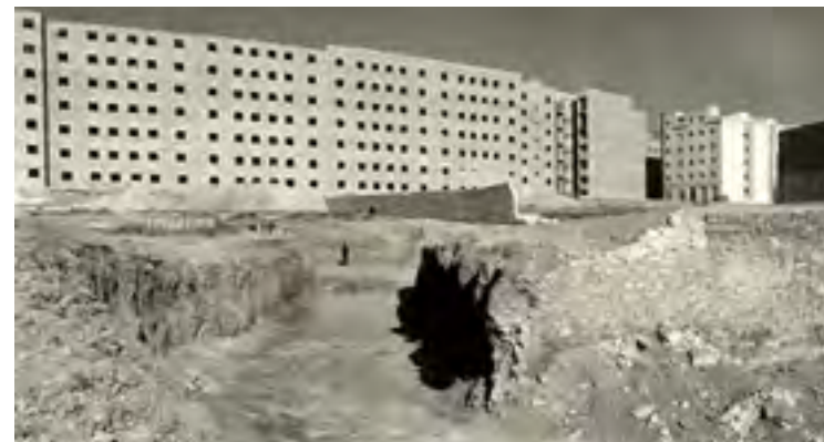
[III_d_1] Barri del turó de la Peira en construcció, a la dècada del 60's
