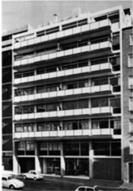
[II.a.4] Façana carrer J. S. Bach
