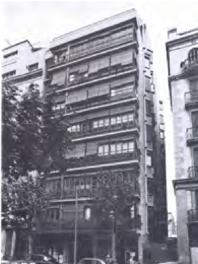
[IV.C.1] Façana carrer Roselló.
