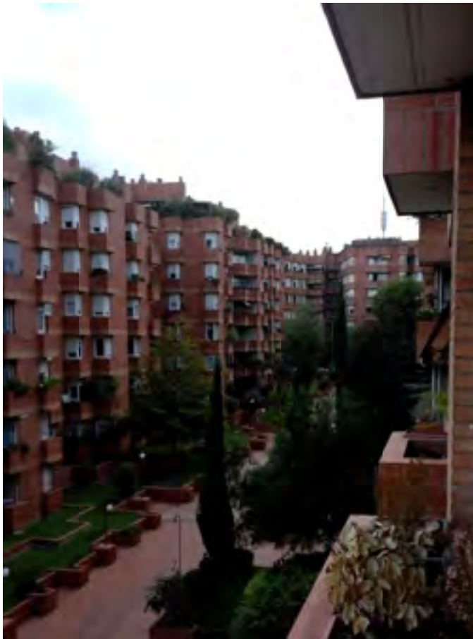
[7.2] Vista des de l'interior d'un habitatge cap a l'exterior a Les Cotxeres de Sarrià.
