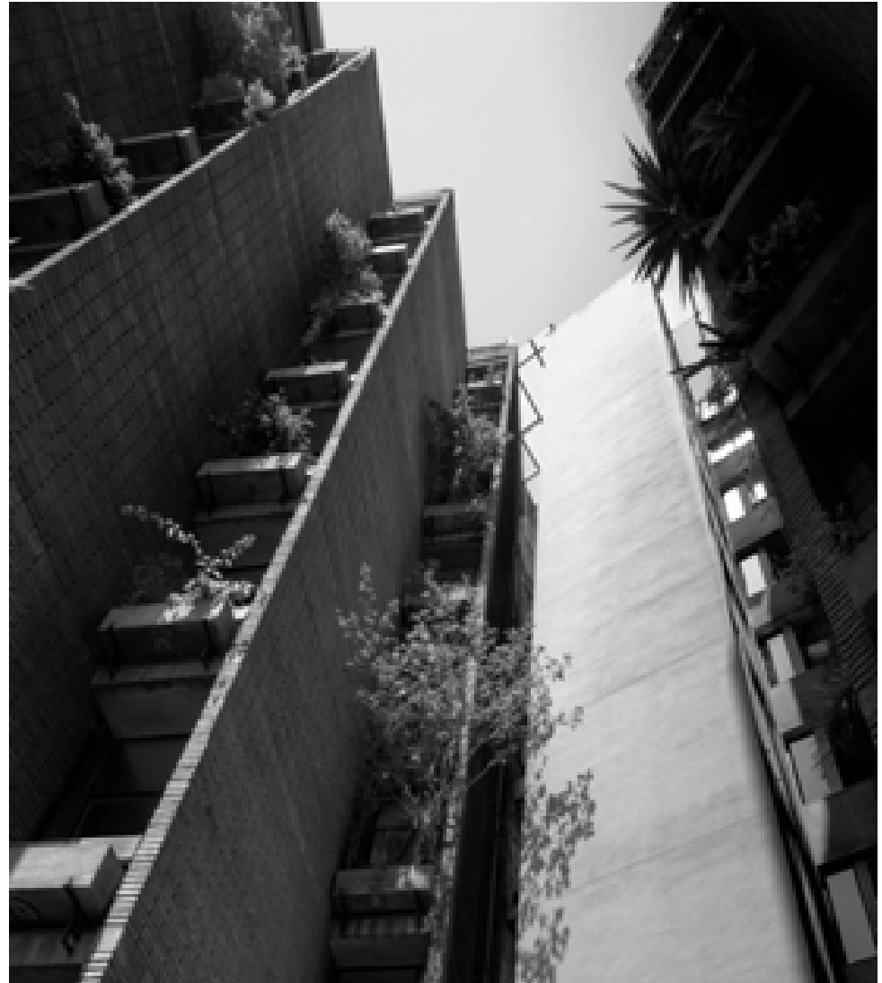
Vista de la caixa d'escala al pati.
