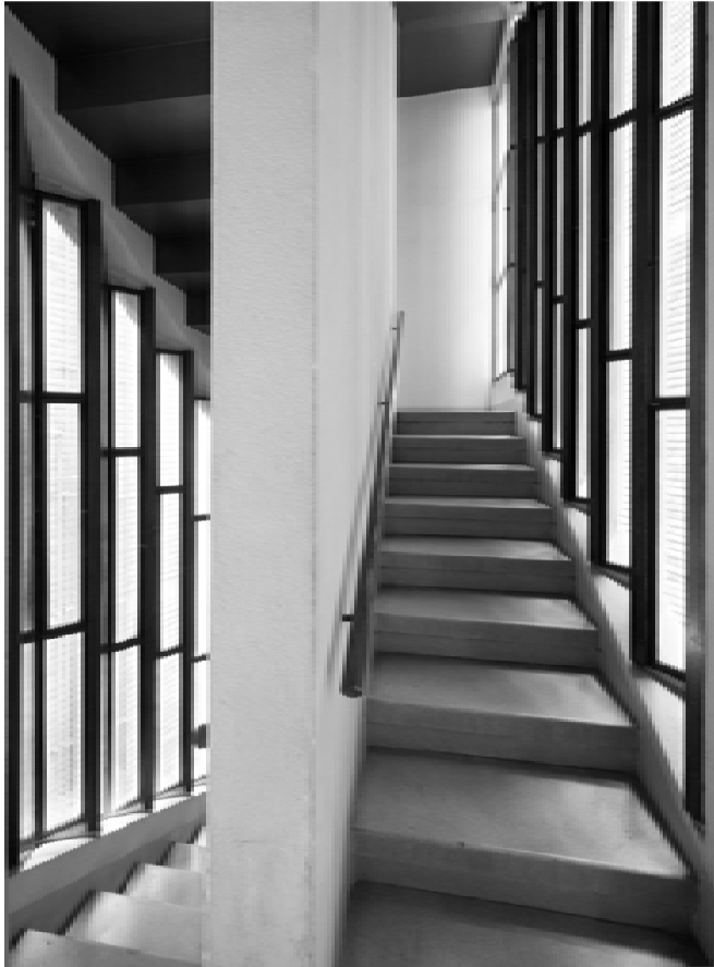
Visió obertures en "dent de serra" de l'escala.
