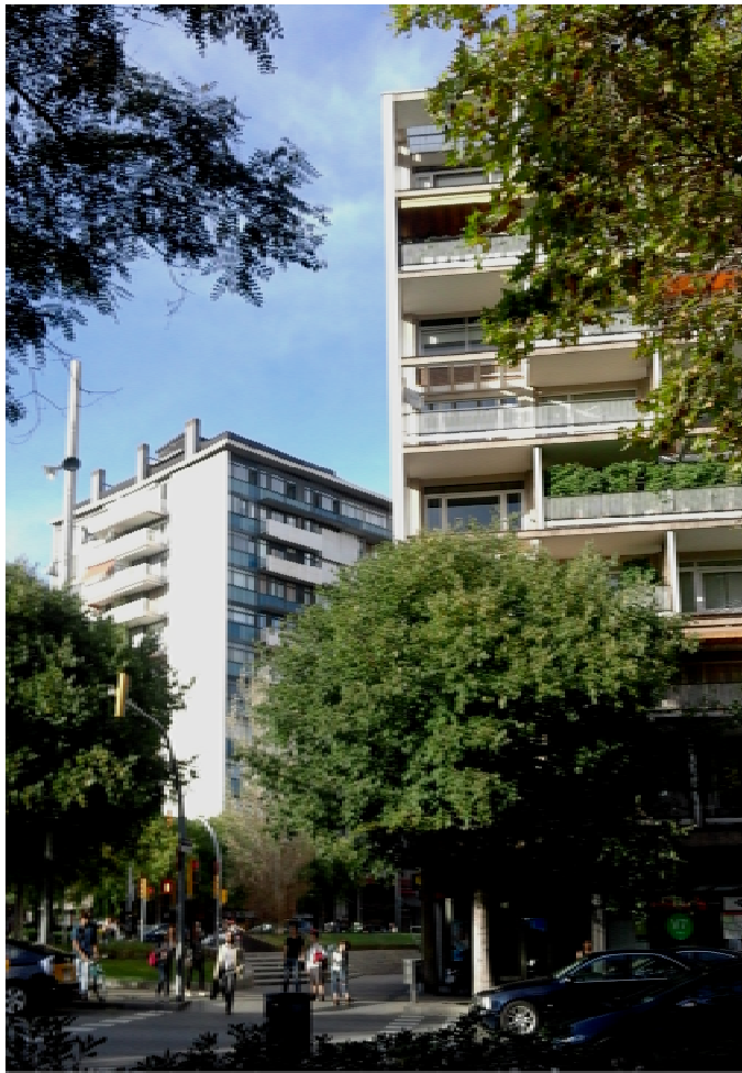
[6.9] Edificis relacionats en context urbà de nus. - B. Corsini i F. Mitjans -.
