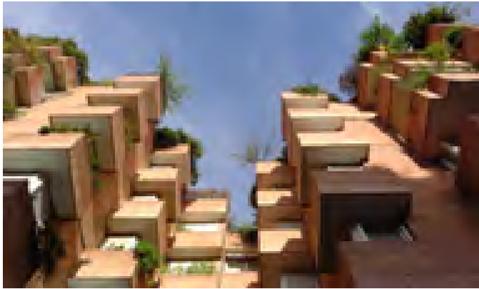
[IV.d.5'] Vista d'esglaonament formal
