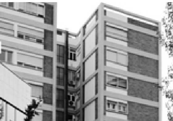
[IV.a.6] Façana posterior. (Entramat estructura)
