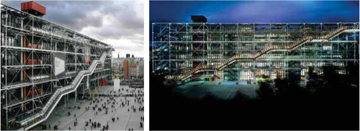
Imagen 3.82: Centro Pompidou (1972-1977) en París, de Richard Rogers y Renzo Piano. Fuente: aauu2012.wordpress.com | blogs.cornell.edu
