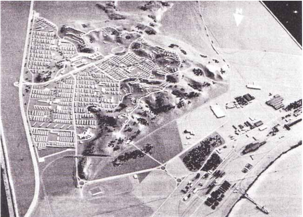
Imagen 3.11: Villa Presidente Ríos. Fotografía de la maqueta del conjunto con la planta Siderúrgica. Fuente: Sánchez, 1960, Op. Cit.
