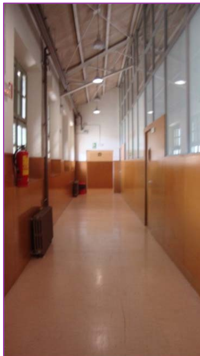
ILUSTRACIÓN 8. PASILLO DELANTE DE LAS AULAS.
