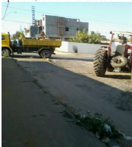
Figura 39 – Trator na periferia, fazendo a retirada de entulho em lugar clandestino
