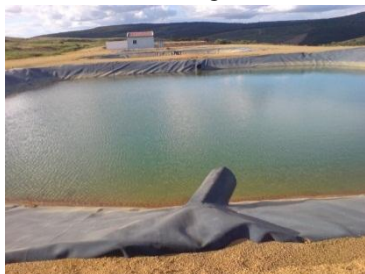
Figura 44 – Primeira lagoa de Tratamento
