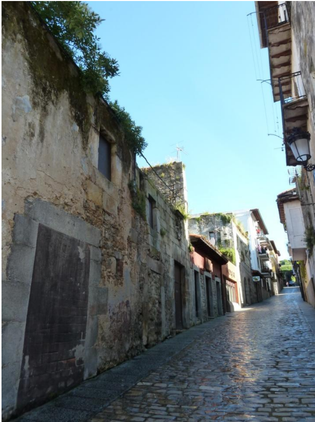
Fotografía 25: Calle de San Marcial (Carnicerías Viejas).
