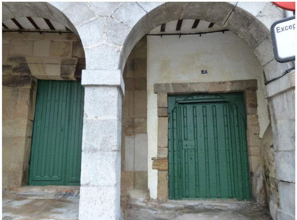
Fotografía 13: Casa Palacio de Zarauz. Detalle de la primera y segunda puertas a la derecha, bajo la arcada. La primera puerta de la derecha es probable que fuese la puerta de Cabe Arnao o Santa María de los Portales.
