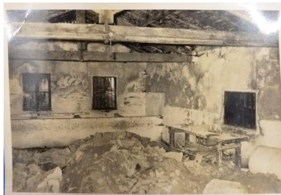
Fotografía 41: Antiguas pilas para lavar pescado de una fábrica de escabeche de la parte trasera de la cestería de la calle Espíritu Santo, antes de su remodelación. Por gentileza de Santiago Zuazo.
