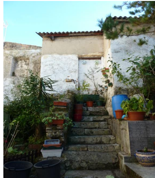
Fotografía 35: Puerta tapiada de acceso al antiguo lavadero del interior del recinto del convento de San Francisco.
