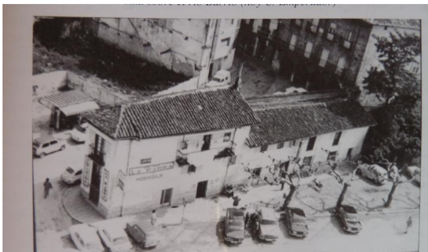
Fotografía 6: Casas construidas sobre el lienzo Oeste, exterior, de la muralla del Arrabal. BRÍGIDO GABIOLA, Baldomero: La Puebla Vieja y el Arrabal de la villa de Laredo. Configuración urbana y realidad social de Laredo en el siglo XVIII . Torrelavega, 2008, p. 353.
