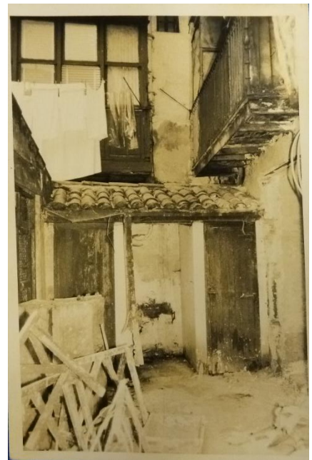
Fotografía 40: Antiguos lavabos del interior de la casa de la cestería de la calle Espíritu Santo, número 15, antes de su remodelación. Por gentileza de Santiago Zuazo.
