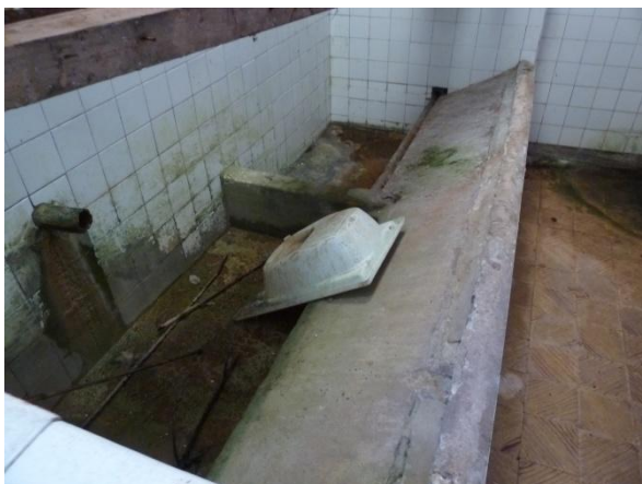
Fotografía 36: Interior del lavadero ubicado en el recinto del convento de San Francisco.
