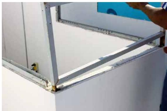
Ilustración 29: Modificación de los módulos para configurar las diferentes inclinaciones de las láminas de las CV. Se Observa el desensamblaje de las estructuras metálicas y el retiro modulado de las secciones de paneles de yeso
