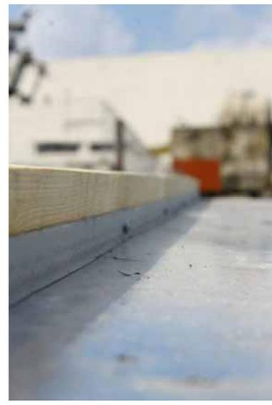
Ilustración 8: Colocación de tablonces de madera para configurar las cavidades ventiladas
