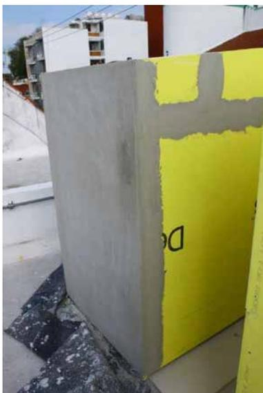
Ilustración 9: Aplicación de acabado a base de cemento en exterior de los paneles
