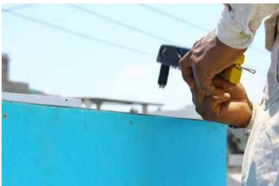
Ilustración 34: Retiro de las láminas superiores de las CV para la configuración de los módulos
