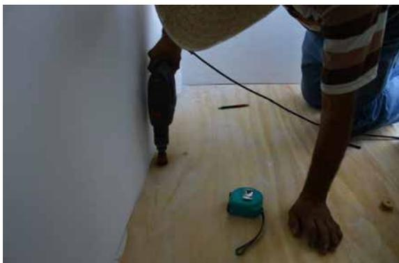
Ilustración 22: Perforación realizada en el piso de los módulos para instalar el ducto por donde se hicieron pasar las sondas para las mediciones interiores de los módulos
