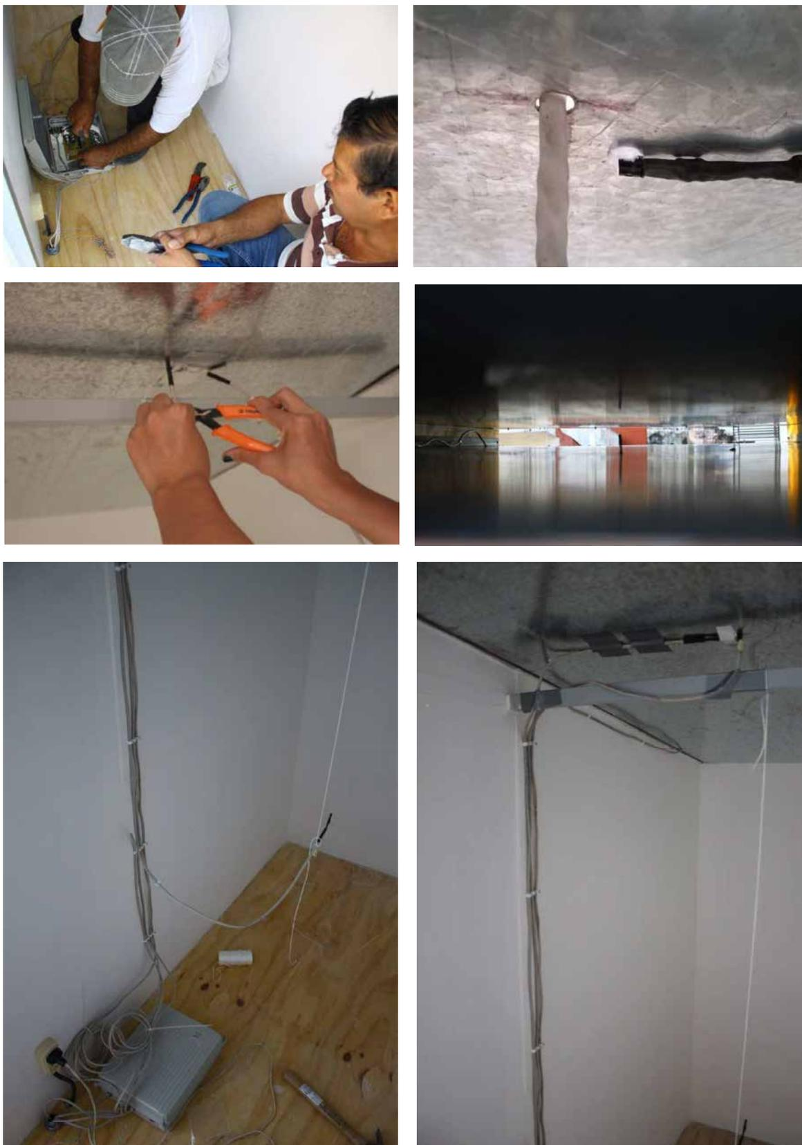
Ilustración 26: Instalación de sensores al interior de los módulos. Se puede observar la aplicación de pasta disipadora entre los sensores y las láminas para garantizar contacto. El colgado de los sensores para las mediciones del aire interior de los modelos y la ubicación del sensor que mide la temperatura del aire al interior de la cavidad ventilada
