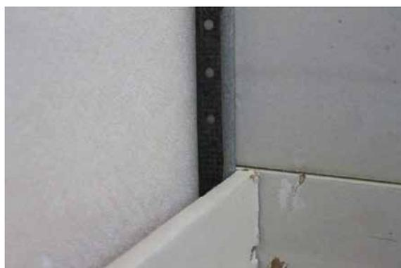
Ilustración 5: Detalle de fijación de las esquinas de los paneles interiores de cartón yeso.
