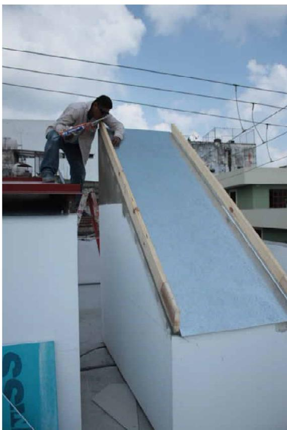
Ilustración 28: Módulo de CV de 36° de inclinación antes de colocar la hoja exterior de la CV
