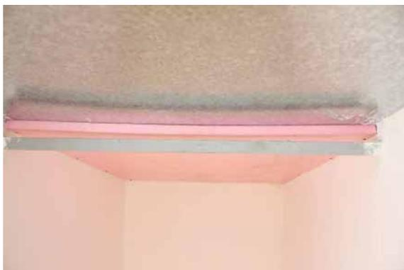
Ilustración 33: Instalación de aislamiento interior en el módulo de CV
