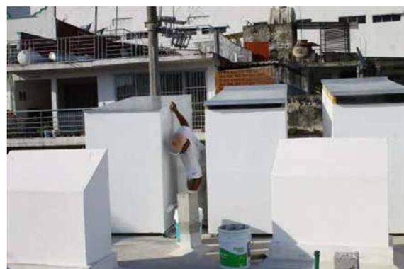
Ilustración 6: Aplicación de pintura blanca en los muros de los módulos
