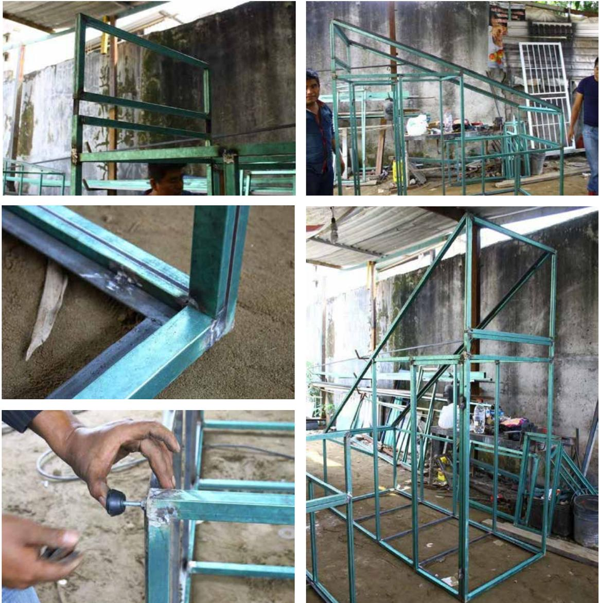
Ilustración 3: Patas roscables en estructuras metálicas para garantizar un correcto nivelado.
