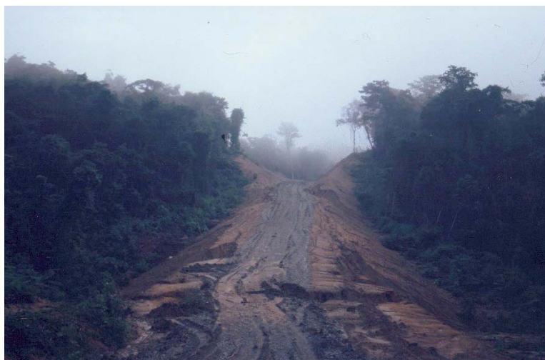
Imagen 2: Construcción de la carretera fronteriza. Tramo por Peña Blanca, diciembre de 1998
