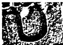
IX.3 Els sistemes d'elevació de la construcció clàssica recorren a ranures acanalades en els blocs petrus per a poder alliberar fàcilment el cordatge.
