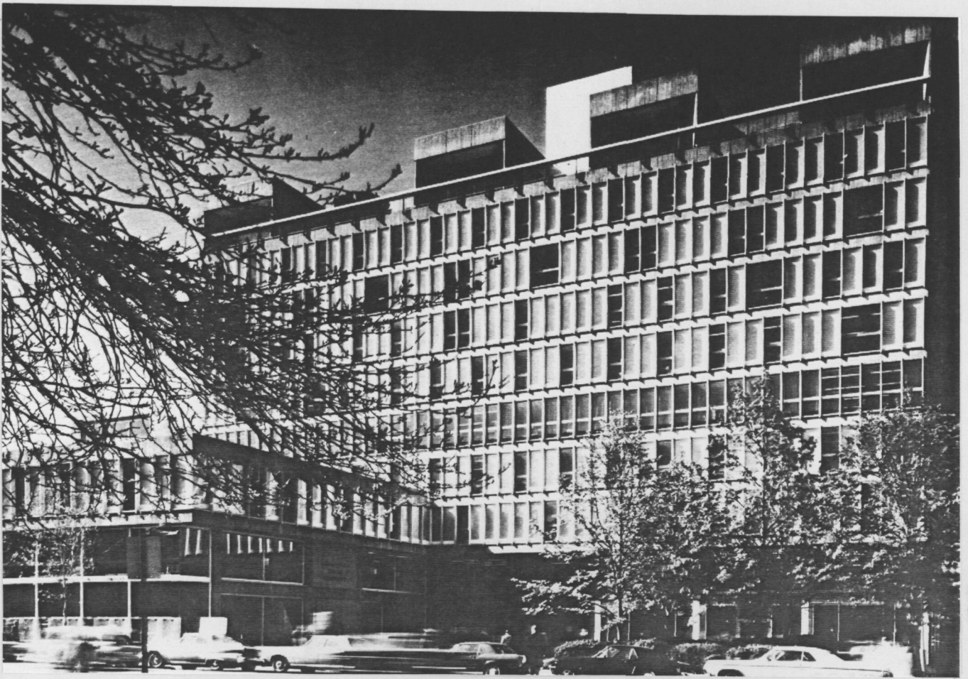
FAÇANA NORD DE HOLYOKE CENTER
