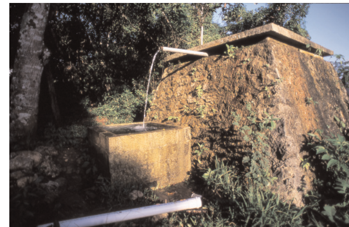
Imagen 34: Tanque de agua. Fotógrafo J. Piqué.
