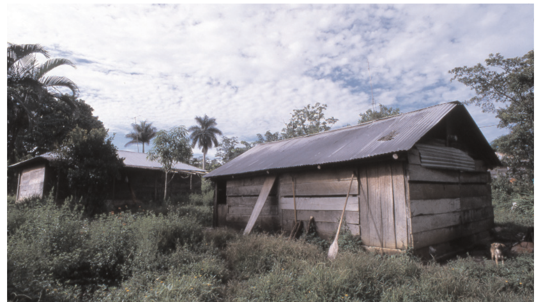
Imagen 94: Dormitorio al fondo y cocina a la derecha, (2003). Fotógrafo J. Piqué.
