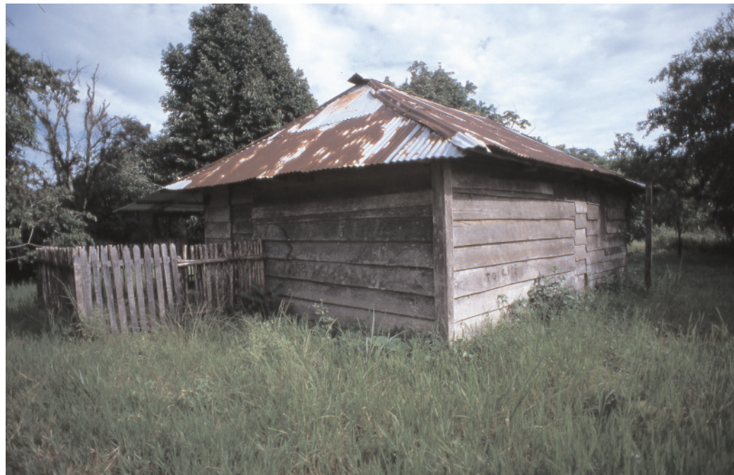
Imagen 95: Dormitorio de la casa 16, (2003). Fotógrafo J. Piqué.
