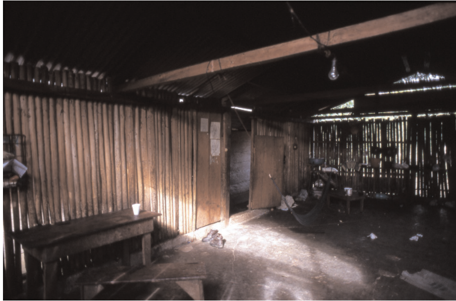
Imagen 131: Material de construcción y muebles. Fotografía J Piqué.
