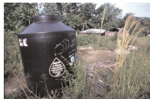
Imagen 120: Instalación sanitaria e hidráulica. Fotógrafo J Piqué.
