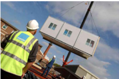
Sistemas constructivos modulares en hormigón (Compact Habit), en madera (Diemodulfabrik KLH) y en acero (Yorkon)
