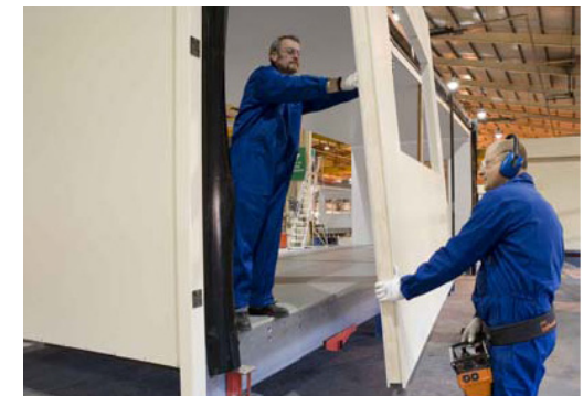
La prefabricación de módulos de acero, según datos de la organización inglesa WRAP supone un volumen reducido de residuos, de alrededor del 1,8% del total de materiales invertidos.
