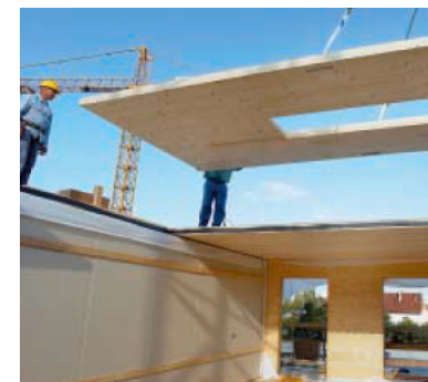
La prefabricación de estructuras de madera, según datos de la organización inglesa WRAP supone un volumen reducido de residuos, de alrededor del 2% del total de materiales invertidos.
