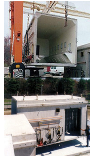
La prefabricación de estructuras de hormigón, según datos de la organización inglesa WRAP supone un volumen reducido de residuos, de alrededor del 2% del total de materiales invertidos.
