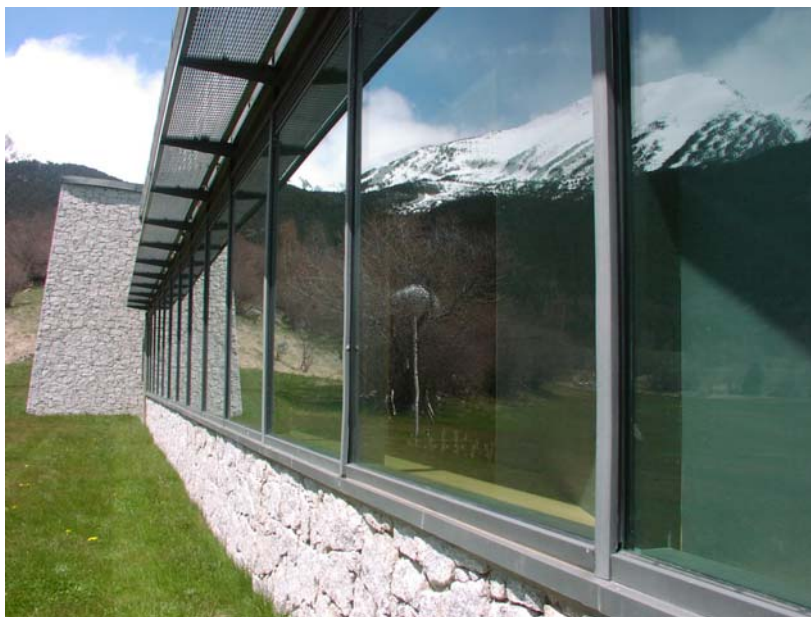
Figura 73: Planes de Son, detalle de los captadores térmicos
