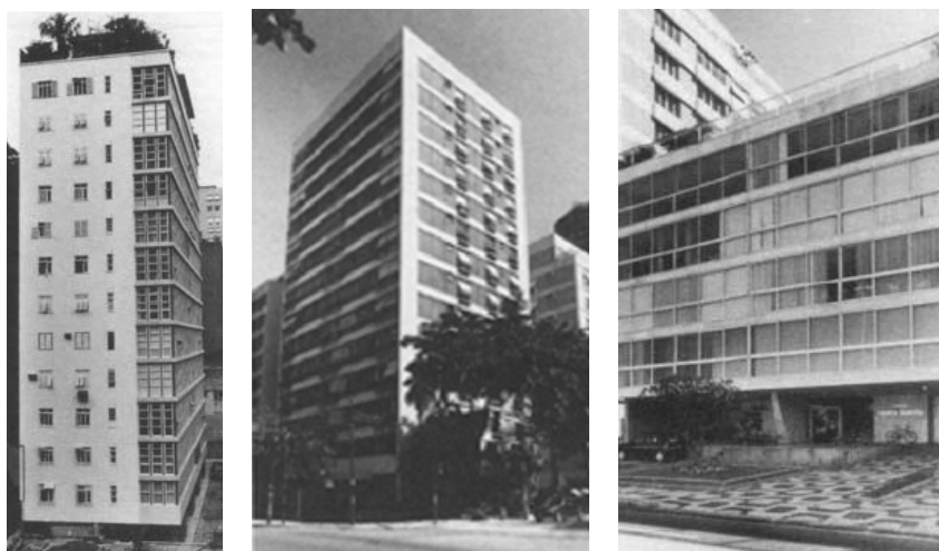
Figura 5.1– Edificios de viviendas sin varandas en Río de Janeiro. Fuente: BRANDÃO, 2009.
