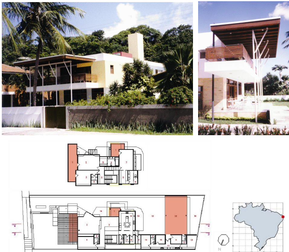
Figura 5.15 – Casa en Cabo Branco, Gilberto Guedes, João Pessoa, 2000. Fuente: CAVALCANTI Y LAGO, 2005.
