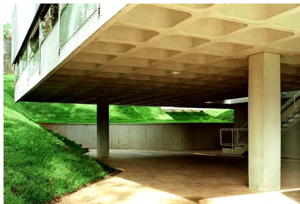
Fig. 5.68 – Pilotis em casa de Ângelo Bucci.
