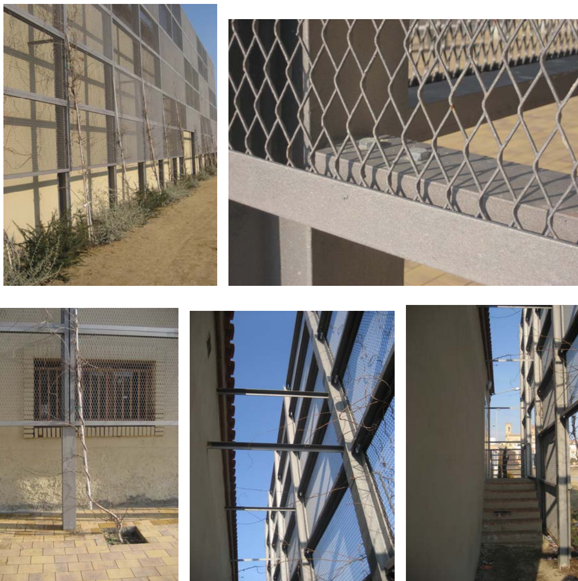
Figura 114. Façana vegetada Golmés. Detalls estructura metàl·lica. Gener 2008
