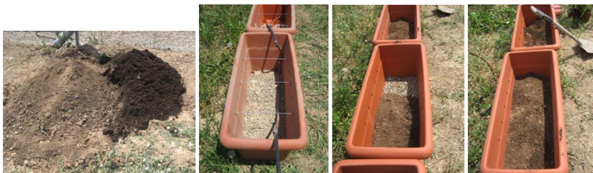
Figura 104. Puigverd. Barreja del substrat amb terra vegetal. Capa de drenatge de grava
