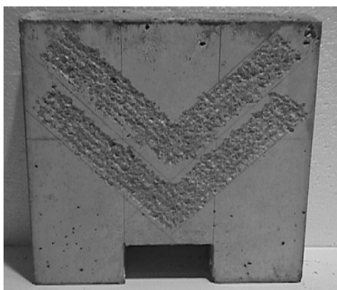
Figura 5.6a Preparación de la superficie del hormigón antes de adherir las láminas de refuerzo
