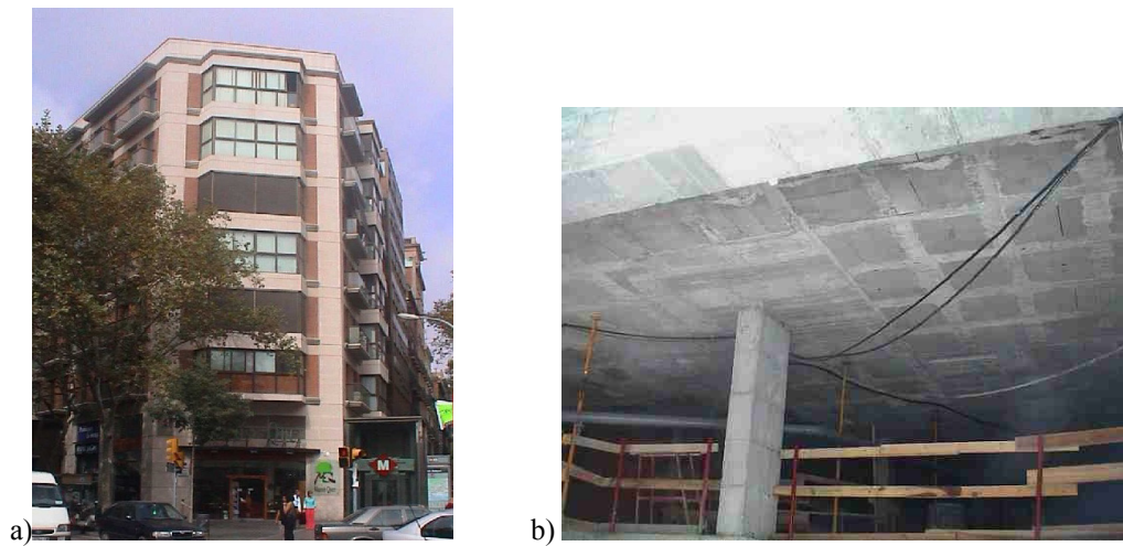
Figura 5.17. Edificio de hormigón armado (a) y detalle de forjado reticular (b).
