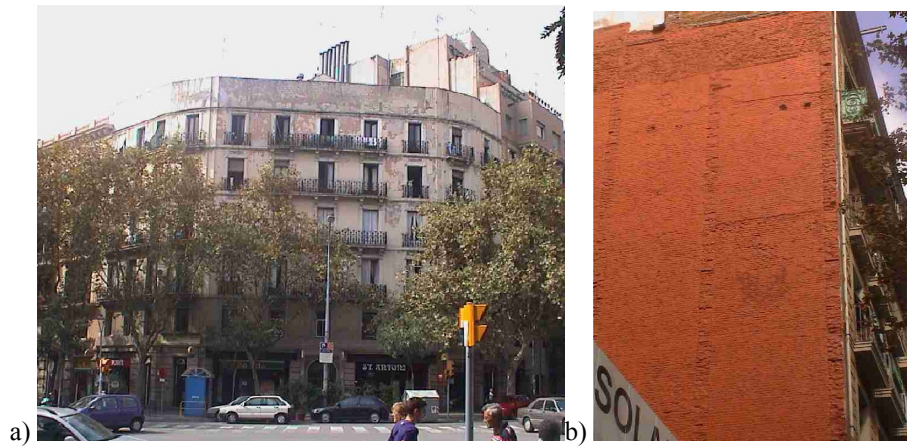
Figura 5.16. Edificio de mampostería no reforzada en el distrito del Eixample (a) y detalle de muros de mampostería (b).
