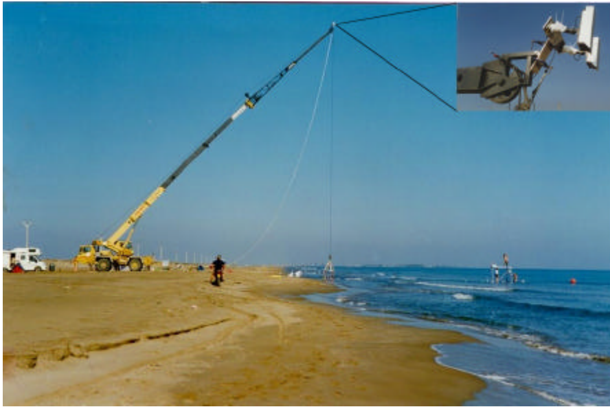
Figura 5.4.- Cámaras de filmación montadas en una grúa de 40 m de longitud.
