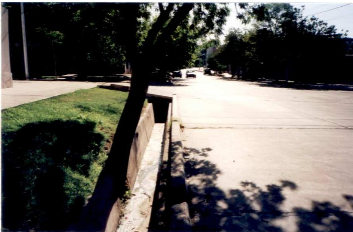
Figura 8-4: Detalle de una sección transversal típica de una calle de Mendoza.
