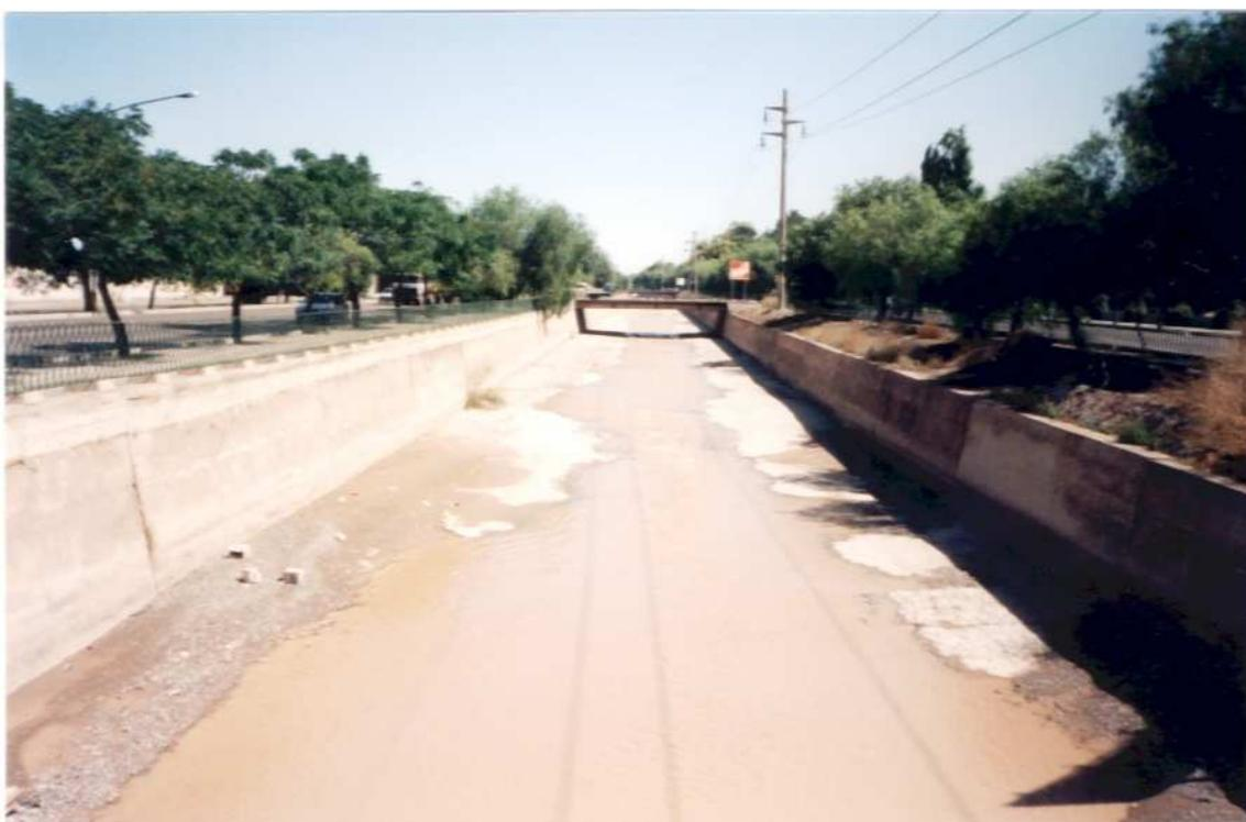
Figura 8-5: Canal Cacique Guaymallén, de riego en tiempo seco y de drenaje en tiempo de lluvia.
