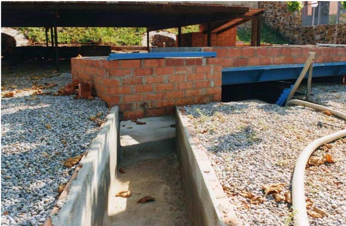
Figura 5-14: Arqueta de salida en la dirección "y".
