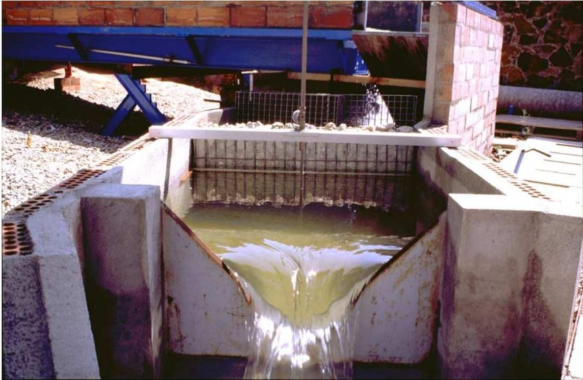
Figura 5-13: Arqueta de salida en la dirección "x".
