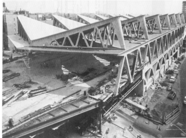
Vista general de la estación y de las conexiones con la trama viaria de la ciudad. Estructura de celosía del edificio.
