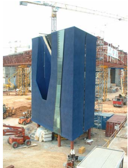
Fig. 5: Maqueta para la divulgación del proyecto, las escalas y entorno, maqueta estudio de los lucernarios, maqueta general de la primera planta y en tamaño natural para mostrar las proporciones, las texturas utilizadas y el comportamiento de la iluminación.
