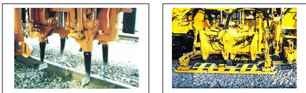
Fig.A2-1: Procesos de compactación del balasto.
