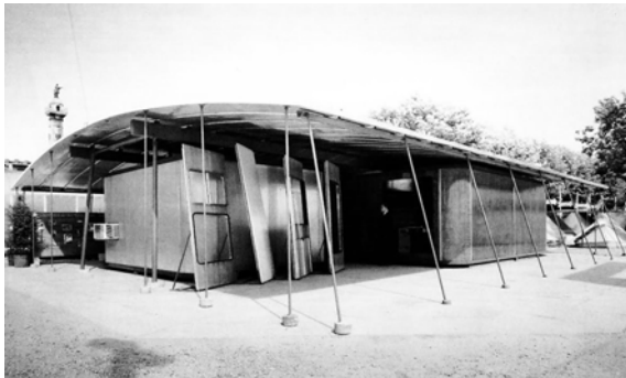
[1.28] Prototipo desmontable para la Maison Saharienne. (Consultado en https://bit.ly/2jlzjG5 )
