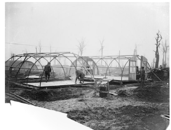
[1.21] Construcción de barracones Nissen en la batalla del Somme, norte de Francia, 1916. (Fotografía Q 4597, Imperial War Museums)
