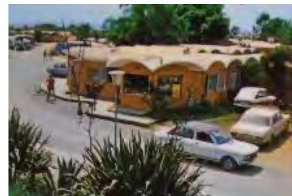
[7.18] Vista del edificio de recepción y supermercado. (Postal nº1621, via Todocolección.net)
