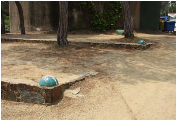
[6.43] Detalle de la delimitación entre parcelas mediante su definición topográfica, muros de piedra e hitos, 2014. (Autor)
