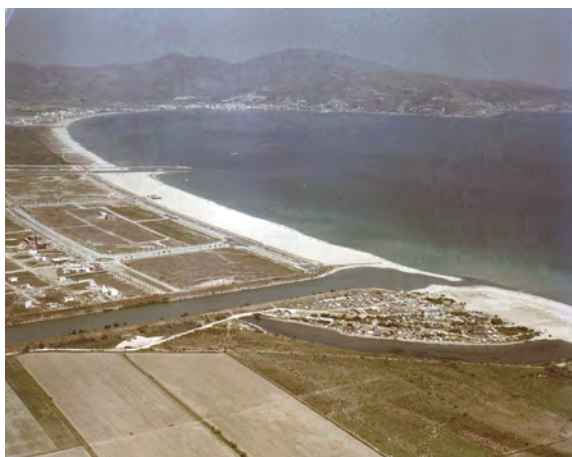
[7.3] Vista aérea del camping Laguna en primer plano y construcción de Empuriabrava al otro lado del río Muga. (Servicios Aéreos SACE, 1962, en ICGC)
