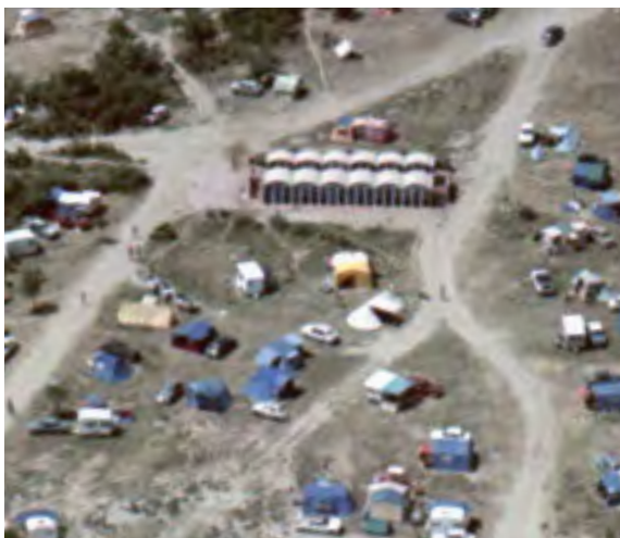
[7.24] Vista aérea del pabellón de servicios original y su posición con respecto a las parcelas cercanas. (Servicios Aéreos SACE, 1969, en ICGC)
