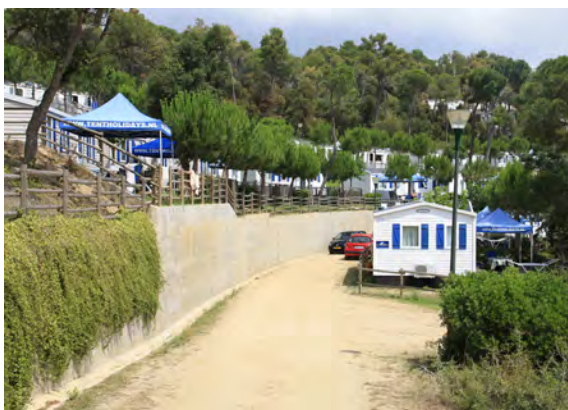
[6.44] Vista de una zona ampliada con el uso de sistemas de contención de tierras que alteran su aspecto original. (Autor, año 2014)
