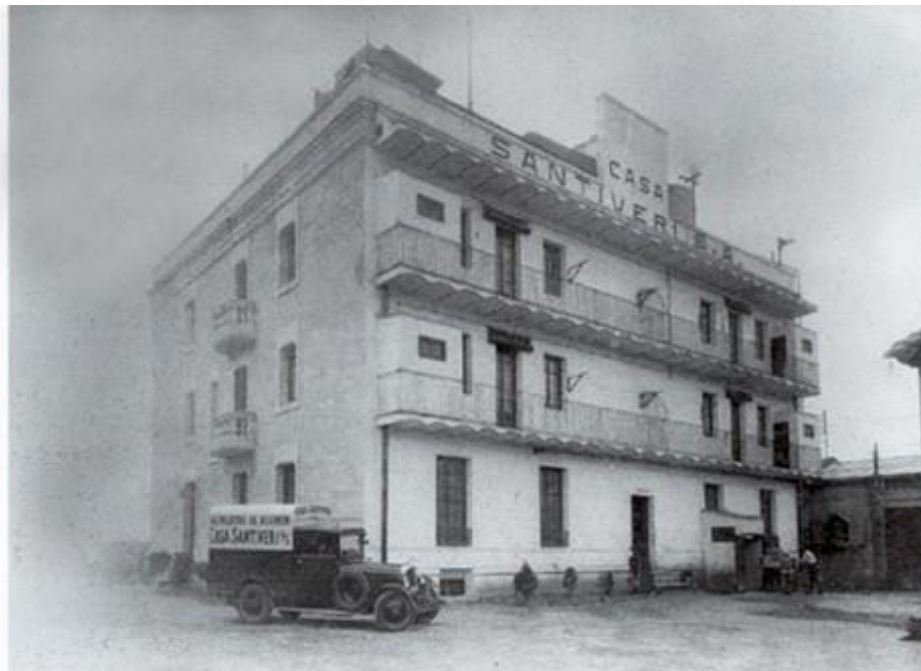
Fàbrica Santiveri Façana posterior de la casa dels amos de l'empresa (part superior). Als Balcons hi havia les oficines.
