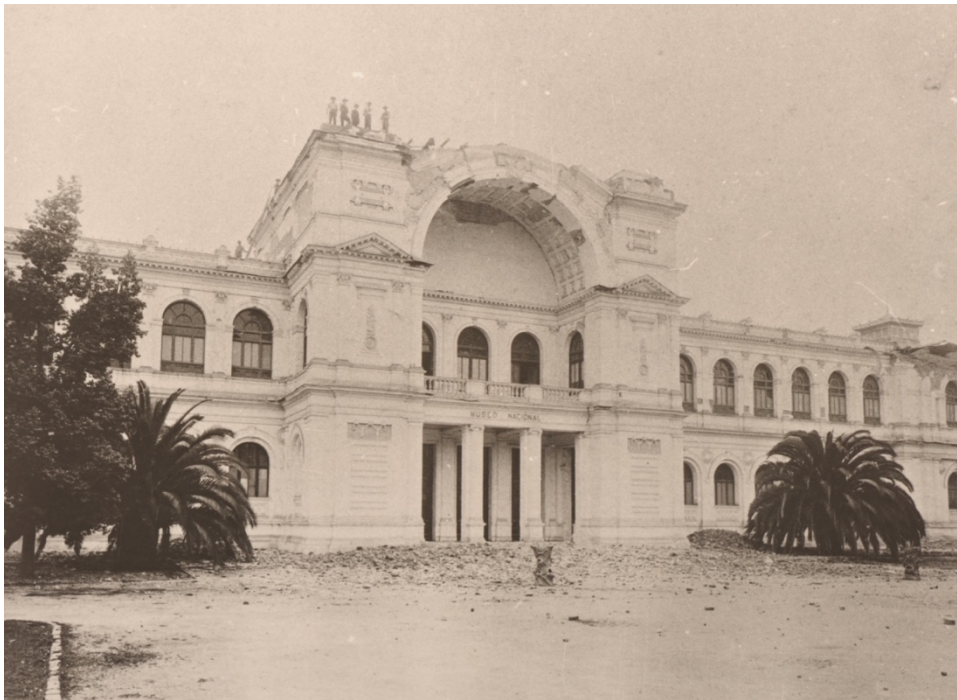
Fig.4. Estado de la fachada exterior del edificio del Museo Nacional después del terremoto de 1927 (Archivo Fotográfico del Museo Nacional de Historia Natural).
