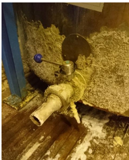
Figura 3.39 Cristal·lització de precipitats de sal al voltant del tub d'evacuació del dipòsit d'emmagatzematge, i a les parets d'aquest.
