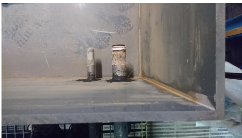
Figura 3.56 Vista zenital de la connexió entre les canonades i el Dipòsit 1.
