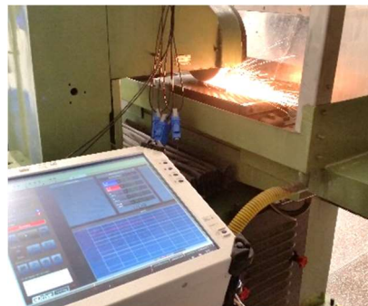
Figura 40. Conexión entre analizador de red Génesis HBM y el motor eléctrico.
