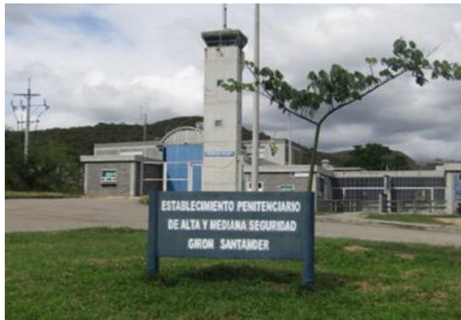
Figura 26. Cárcel de Girón Santander 2001 Fuente: http://www.Inpec.gov.co/web/guest/institucion/organizacion/establecimientos-penitenciarios/regional-oriente/epams-giron
