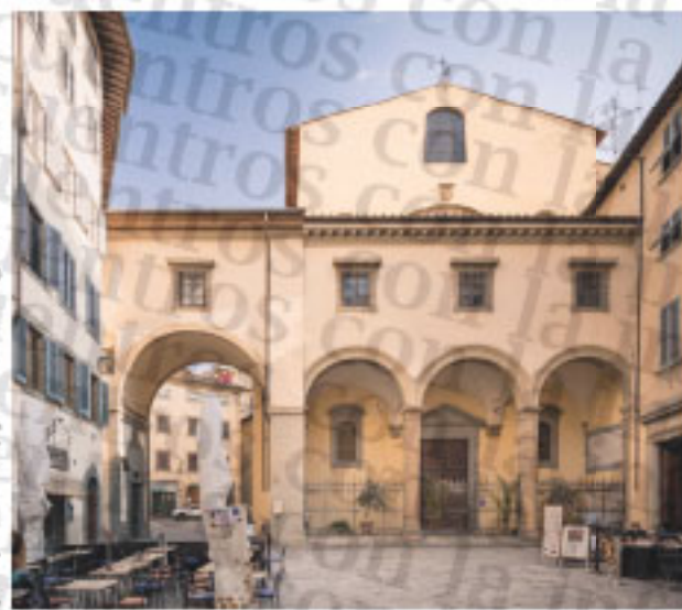
(F02) Alzado del pórtico de acceso de la iglesia de Santa Felicità con el Corredor Vasariano adosado. (F03) Sección y planta de la iglesia de Santa Felicità.
