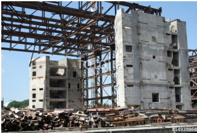
Abajo: Detalle de desmontaje. Foto: Adobe. Fecha desconocida.entre 2006 y 2009.
